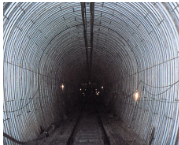
トンネル(馬蹄形アーチ)
